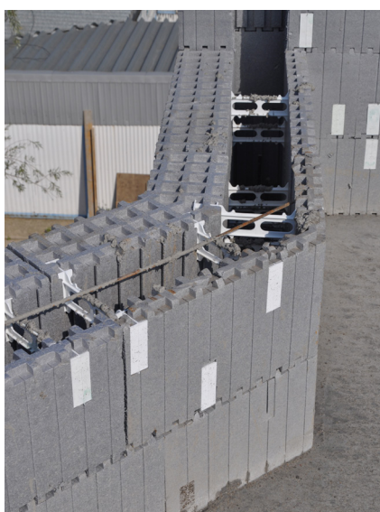
Využití kloubových prvků pro vytvoření rohů s jakýmkoliv úhlem.
