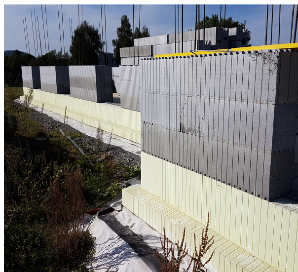
Obr. 2 Schématická konstrukce základové desky využívající přídavné tepelné izolace.
